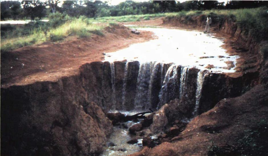
*Photo 2.3 : Phénomène d'érosion régressive dans un chenal non revêtu placé à l'aval d'un déversoir frontal rejeté en rive*
