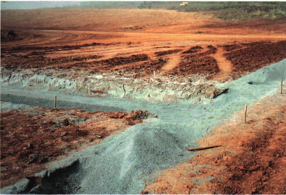
*Photo 3.1 : Confection d'un drain-cheminée (au premier plan) et d'une lanière drainante (au second plan) - Barrage de la Comoé (H = 20 m), Burkina Faso.*
