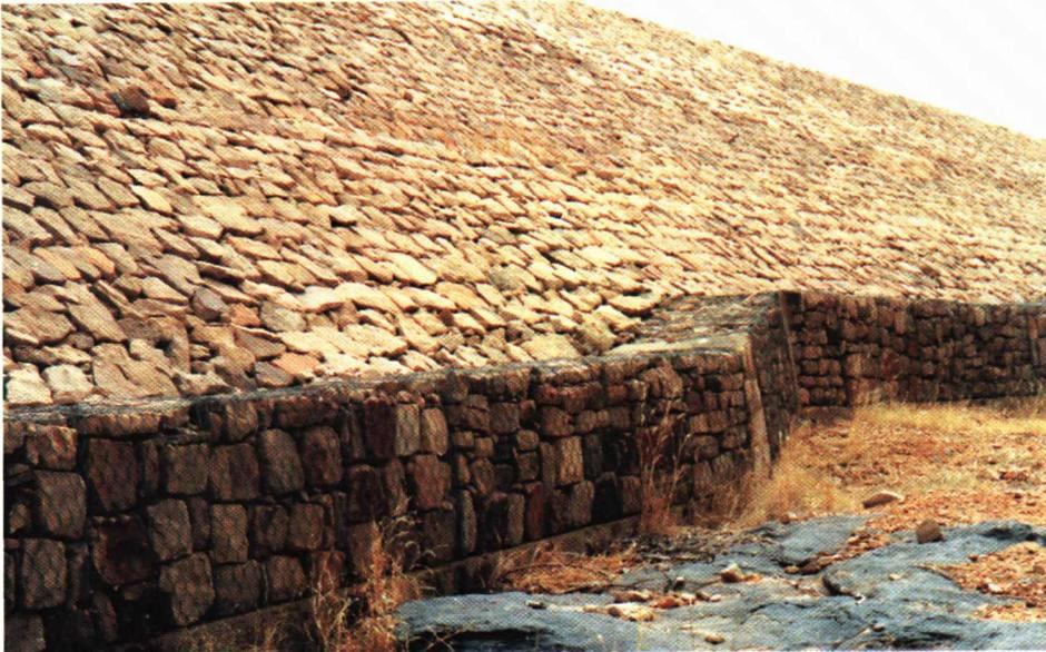
*Photo 3.6 : Barrage de Daga-2 : détail du parement aval ; noter la présence d'une rangée de gabions à titre de blocage de pied.*
