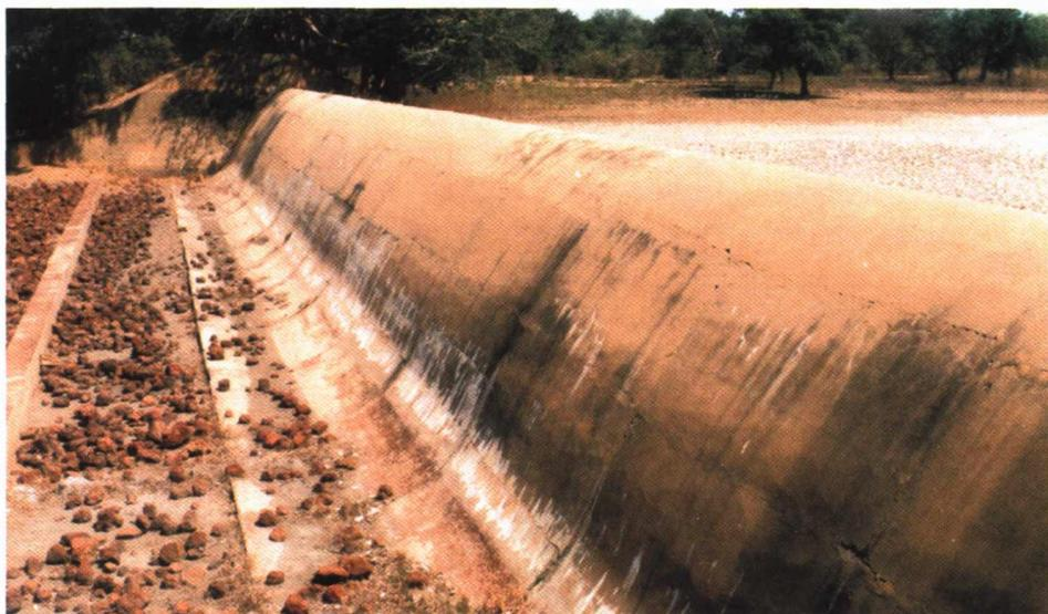
*Photo 2.2 : Barrage de Tia (Burkina Faso) ; déversoir-poids en béton à profil Craeger ; remarquer les nombreuses fissures et les problèmes de reprise de bétonnage ; noter également au second plan les gros arbres qui ont envahi le remblai.*
