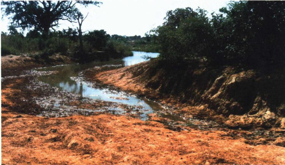
*Photo 1.2 : Barrage de Sao (Burkina Faso) ; vue de l'extrémité aval du chenal qui prolonge l'évacuateur latéral ; remarquer l'importance de la ravine née de l'érosion régressive. Noter l'abondant débit de fuite dû à la présence d'argiles à canaux en fondation.*
