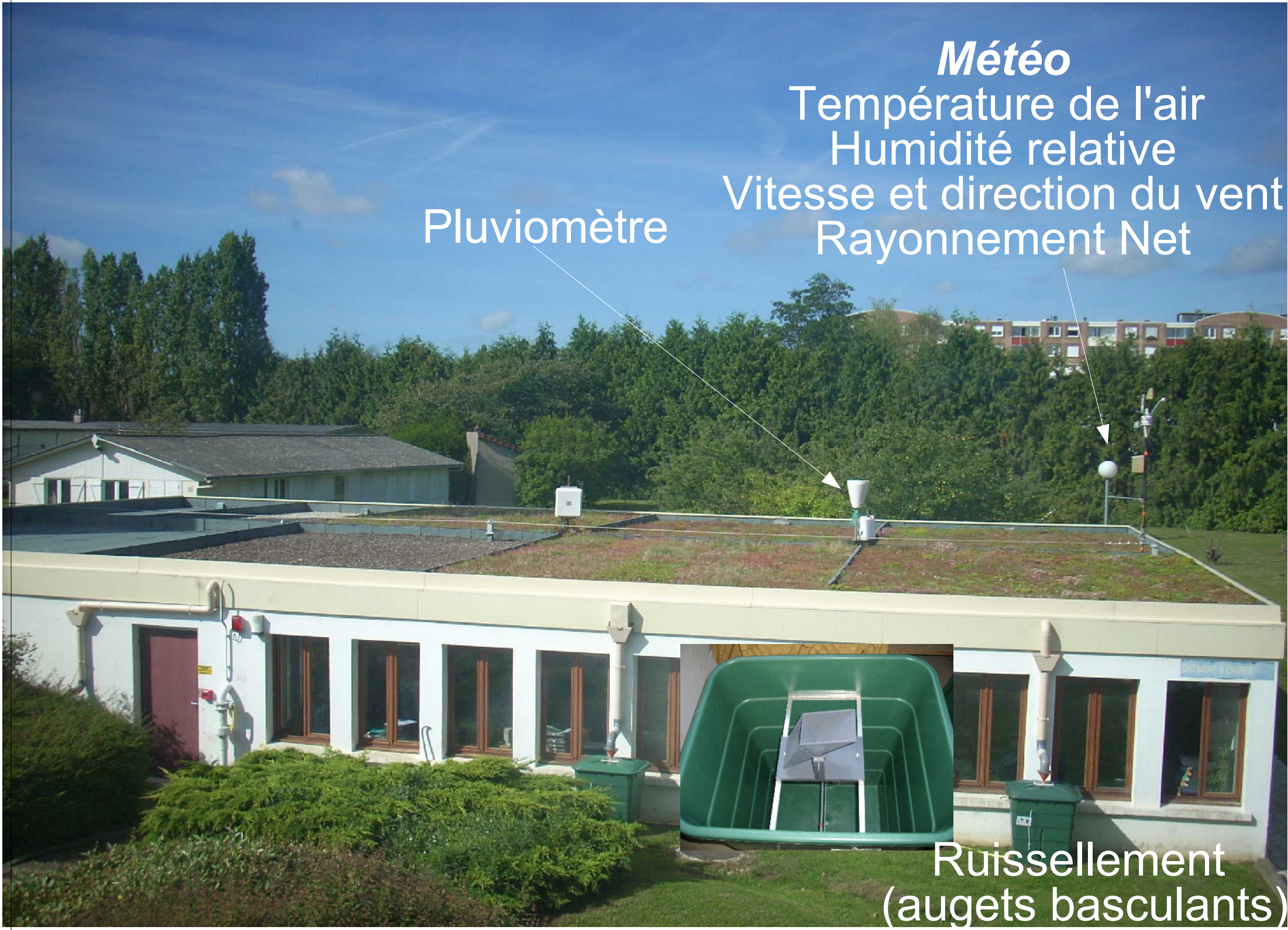
Figure 4 : Dispositif de mesure de la toiture végétalisée. Pluie, météo et ruissellement.
